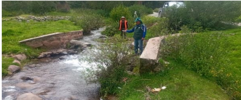
FIGURAS N°01: IDENTIFICACIÓN DE PUNTO CRÍTICO EN EN LA QDA. TUCURA-CHOSECANI CCAYLLAMAYO C. C. SAN PEDRO K'ACHA, DISTRITO SAN PEDRO, PROVINCIA CANCHIS - CUSCO, SE APRECIA UNA BOCATOMA AFECTADO EL BARRAJE. POR LAS ÚLTIMAS AVENIDAS DE PERIODO 2022 - 2023
