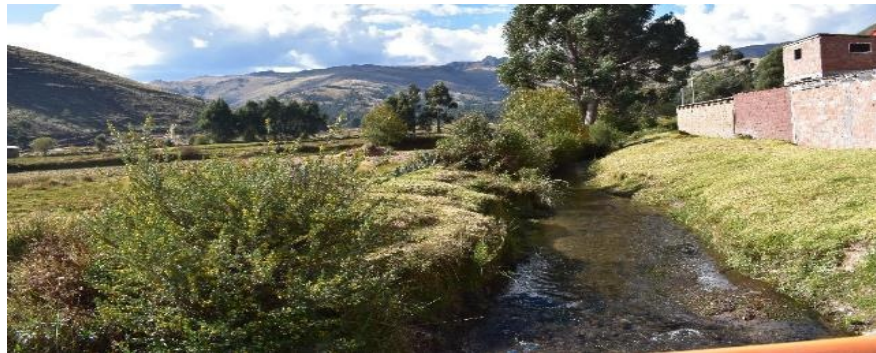
FIGURA N°02: SE APRECIA EL CAUCE ESTRANGULADO Y COLMATADO, ASÍ MISMO TALUDES NATURALES Y AFECTADO AL PIE DE TALUD MARGEN DERECHA AGUAS ABAJO.
